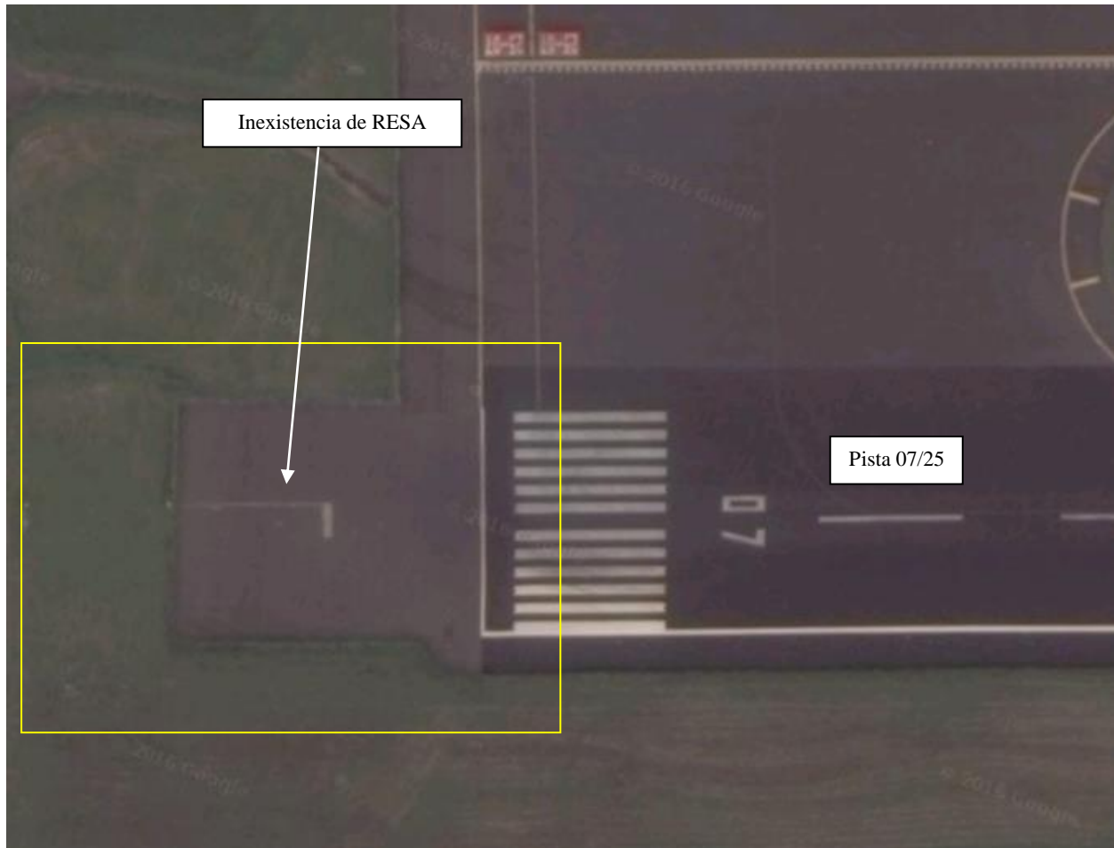
Imagen 2 Inexistencia de Área de Seguridad de Extremo de la Pista 25
