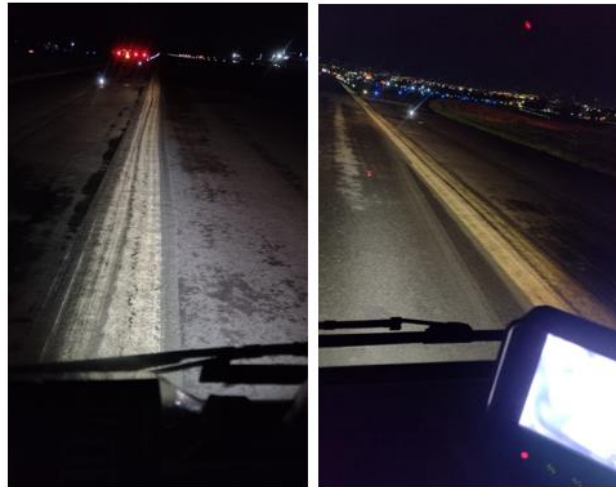
Limpeza y Remoción de Caucho en Pista
