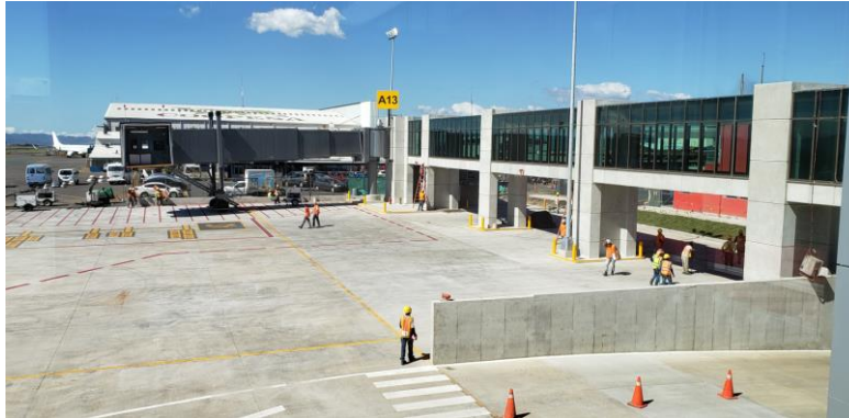
Interior del Puente Fijo del Puente de abordaje No. 13
