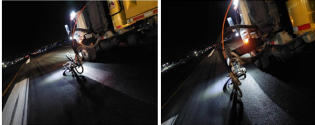
Equipo de Remoción de caucho iniciando con el texturizado a una presión de 28,000 psi
