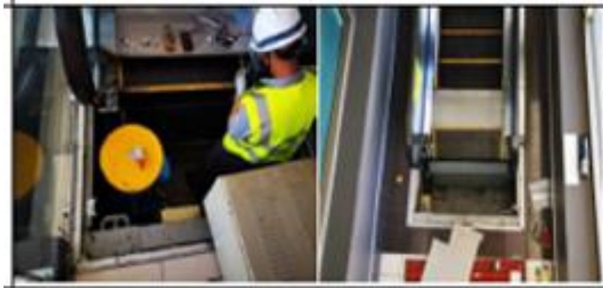
Mantenimiento mayor escalera eléctrica sobre puente A3 y A4
